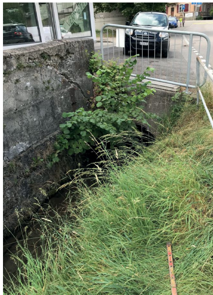
Abb. 28 Einlauf des Chuderglunggebächli auf Höhe Lützelflühstrasse 4
