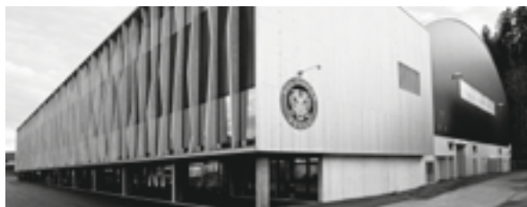
Sanierung & Erweiterung Ilfishalle, zinsloses Darlehen, Bereich innovative regionale Angebote
