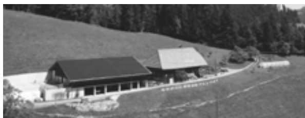
Förderung Solarstrom Emmental Projektbeitrag à fonds perdu, Bereich Industrie
