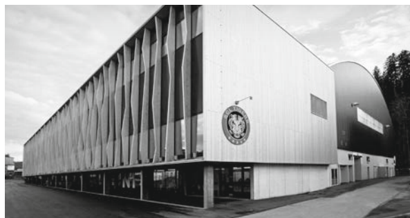
Sanierung & Erweiterung Ilfishalle, zinsloses Darlehen, Bereich innovative regionale Angebote
