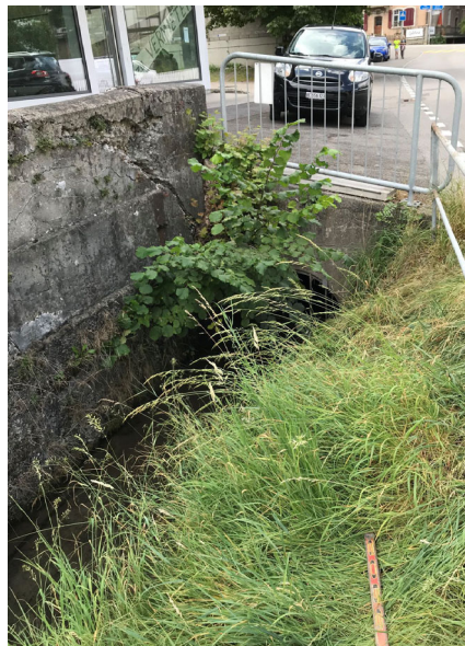
Abb. 28 Einlauf des Chuderglunggebächli auf Höhe Lützelflühstrasse 4
